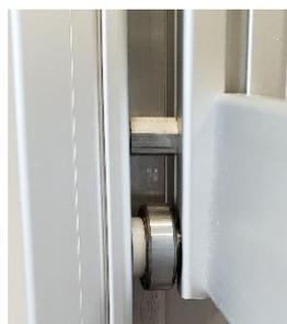
↪ Roulement à bille permettant un meilleur coulissement du châssis mobile sur le châssis fixe.
